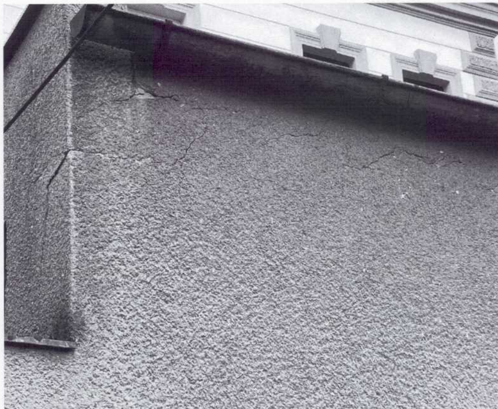
Obr. č.3: Pohled na jihovýchodní roh fasády - trhlina vyvolané deformacemi stropních panelů ve vodorovném směru vlivem teplotních změn.
